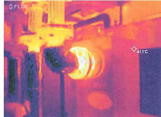
サーモカメラによる配管の放熱状況の計測
